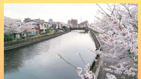
新川護岸耐震補強工事と新川千本桜計画を推進しました。
