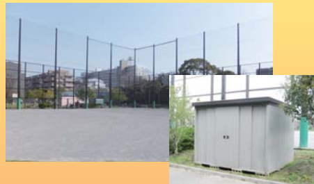
宇喜田公園のグラウンドを改修し、フェンス、倉庫の改修を行いました。
