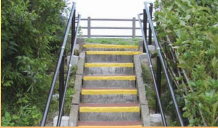
新中川の階段を改修し、手すりを新設しました。
