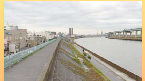
中川の堤防の強化と整備を推進しました。
