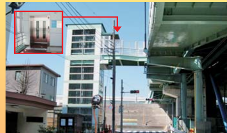
船堀橋にエレベーターとスロープを設置しました。
