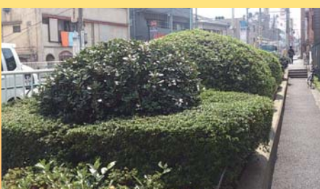
植樹帯の改修・整備を行いました。
