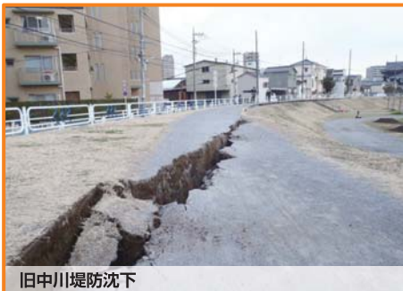
旧中川堤防沈下
