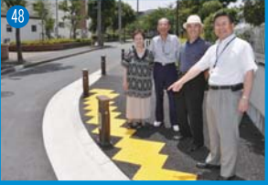
● 道路を広く改修
