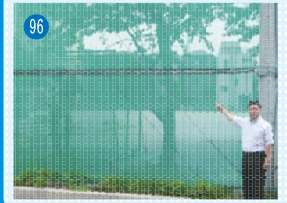
防砂ネットの設置 砂ぼこりが多く困っているという相談があり、瑞江第三中学校に防砂ネットを設置。
