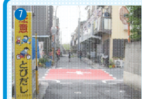
交差点の安全対策 春江町3-27の交差点で接触事故が多く、飛び出し注意の看板や交差点中央にカラー舗装を実施。
